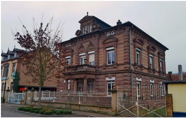
Straßenansicht der Villa in der Bahnhofstraße 14 in Alsenz (Arno Mohr, 2018)
