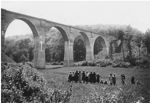
Alte Aufnahme der Bockbachtalbrücke. Vor der Brücke steht eine Menschengruppe (Wolfgang Röhrig)
