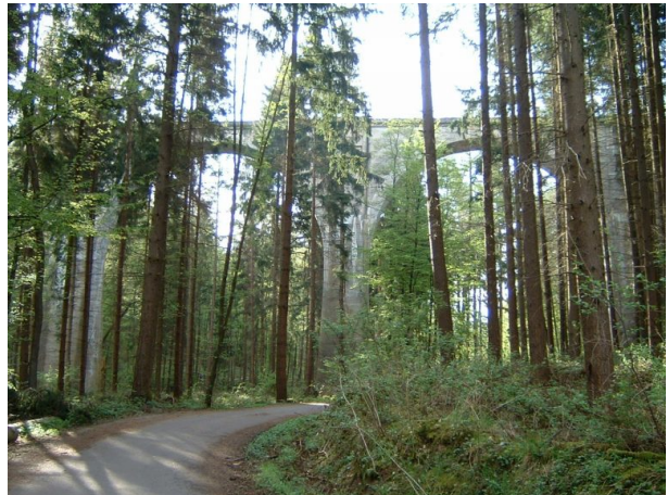
Bockbachtalbrücke bei Ramsen mit darunter hindurchführendem Forst- und Wanderweg (Jürgen Wachowski, 2003)
