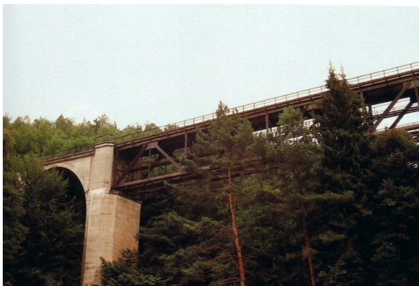
Teilansicht der Eiswoogbrücke (Jürgen Wachowski, 2002)
