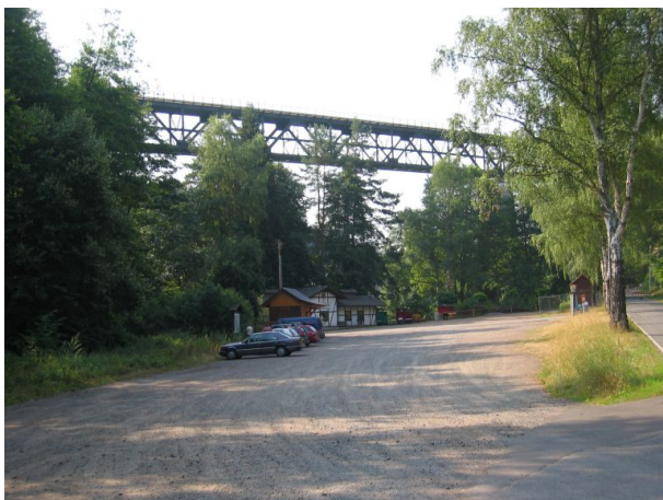
Blick auf die Stahlkonstruktion des Eistalviadukt vom nördlich des Eiswoogs gelegenen Parkplatzes (Wolfgang Röhrig, 2006)
