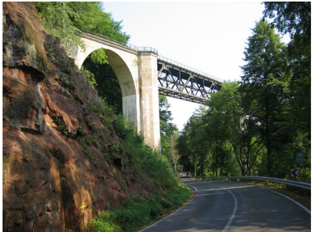
Blick von der Landstraße aus Südwesten auf das Eistalviadukt (Wolfgang Röhrig, 2006)
