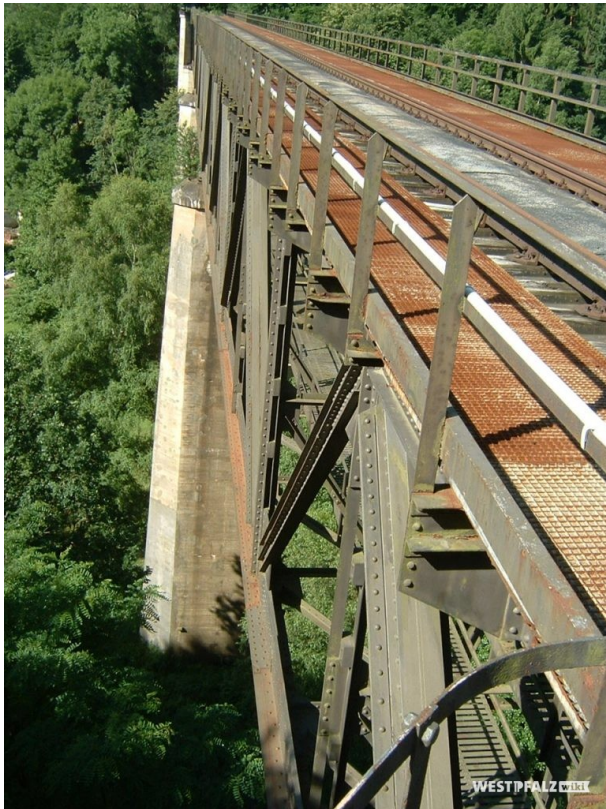
Blick entlang der Schienen über die Eiswoogbrücke (Jürgen Wachowsk, 2003)
