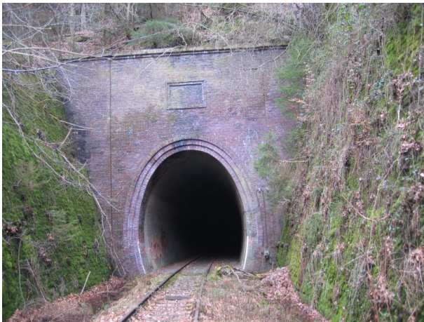
Ostportal des Stempelkopftunnels. (Wolfgang Rörig)
