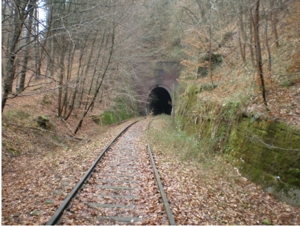
Blick in Richtung des Westportals des Stempelkopftunnels. (Jürgen Wachowski, 2007)
