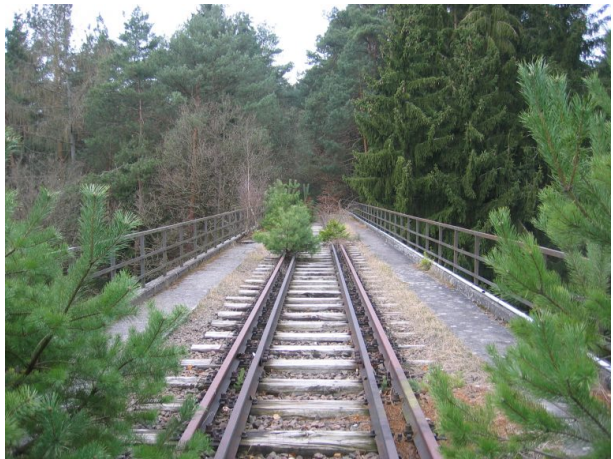
Gleise auf dem zugänglichen Teil des Eistal-Viadukts. (Wolfgang Rörig)
