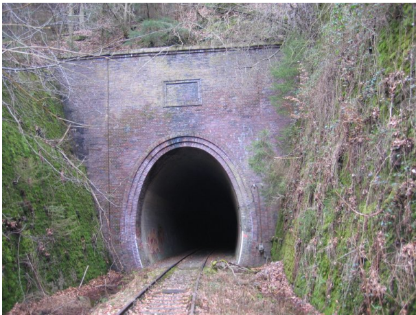
Ostportal des Stempelkopftunnels. (Wolfgang Rörig)
