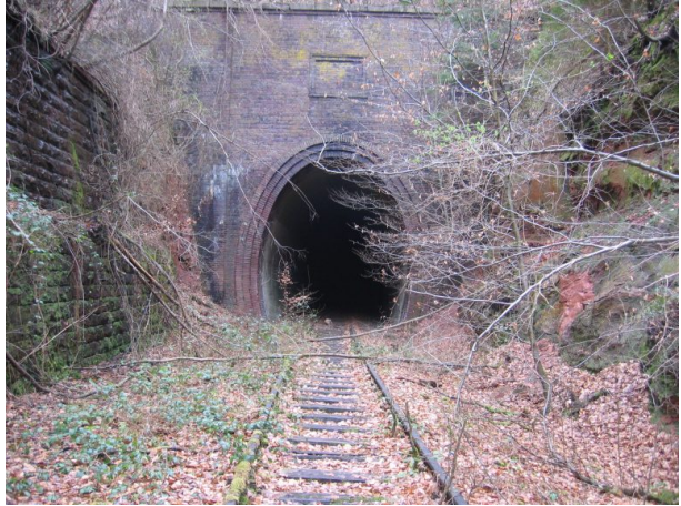
Westportal des Stempelkopftunnels. (Wolfgang Rörig)
