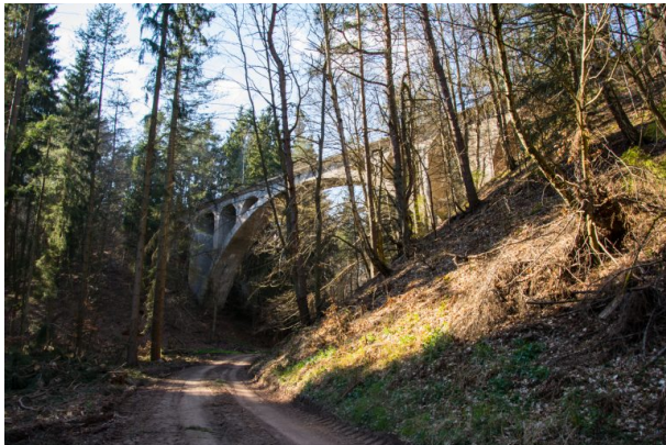
Dreibrunnentalbrücke im Stumpfwald (Sonja Kasprick, 2020)
