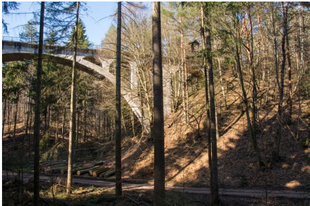
Dreibrunnentalbrücke im Stumpfwald (Sonja Kasprick, 2020)
