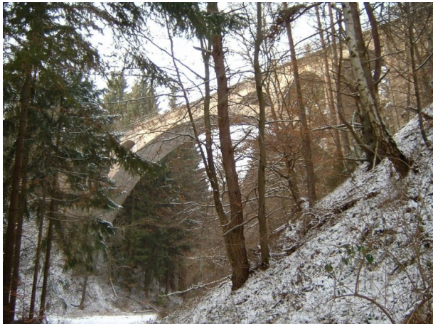
Dreibrunnentalbrücke im Stumpfwald (Jürgen Wachowski, 2006)
