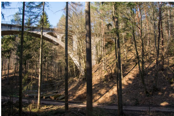
Dreibrunnentalbrücke im Stumpfwald (Sonja Kasprick, 2020)
