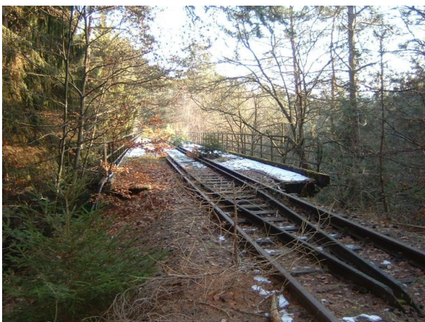
Dreibrunnentalbrücke im Stumpfwald. (Jürgen Wachowski, 2006)
