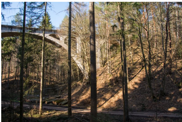
Dreibrunnentalbrücke im Stumpfwald (Sonja Kasprick, 2020)
