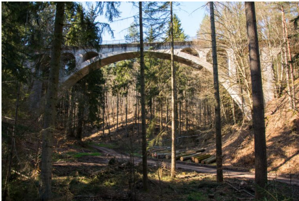
Dreibrunnentalbrücke im Stumpfwald (Sonja Kasprick, 2020)
