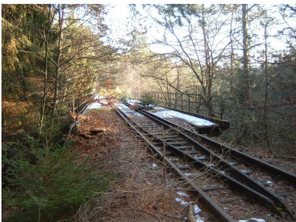
Dreibrunnentalbrücke im Stumpfwald. (Jürgen Wachowski, 2006)
