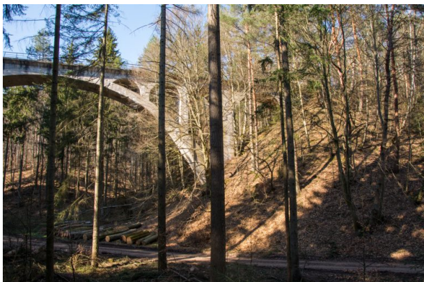
Dreibrunnentalbrücke im Stumpfwald (Sonja Kasprick, 2020)
