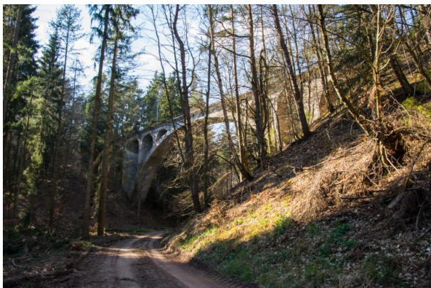
Dreibrunnentalbrücke im Stumpfwald (Sonja Kasprick, 2020)
