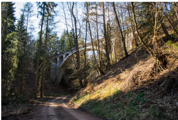
Dreibrunnentalbrücke im Stumpfwald (Sonja Kasprick, 2020)
