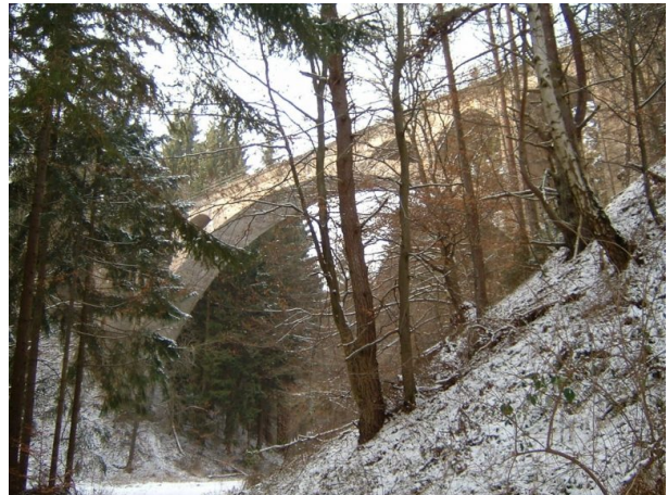
Dreibrunnentalbrücke im Stumpfwald (Jürgen Wachowski, 2006)
