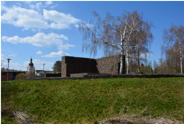
Blick auf die Ostseite der Burgenrekonstruktion (Sonja Kasprick, 2020)
