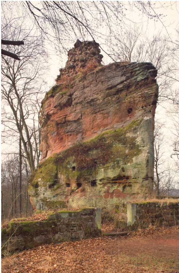
Burgruine Beilstein. Hauptburg. Blick aus dem östlichen Teil auf den Burgfelsen. Im Vordergrund die Quermauer mit der südlichen der beiden Türen zum westlichen Teil der Burg. Ansicht von Osten. (Bernd Barth, 2003)
