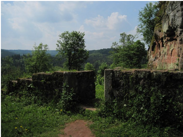
Quermauer mit der südlichen der beiden Türen zum westlichen Teil der Burg. Ansicht von Norden. (Bernd Barth, 2010)
