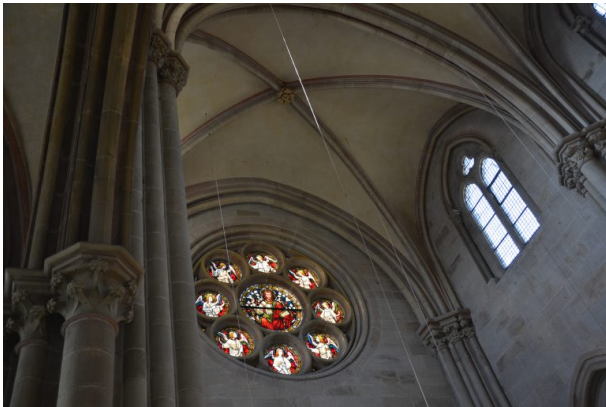
Kreuzrippengewölbe mit Abschlussstein sowie eine Fensterrose über dem Westportal der Abteikirche Offenbach-Hundheim (Sonja Kasprick, 2019)
