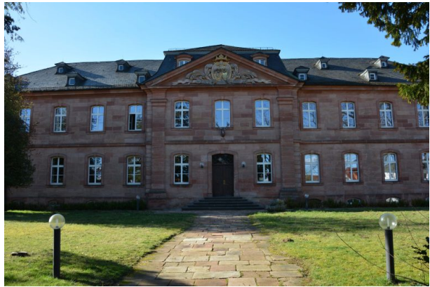
Ansicht des Trippladter Schlosses von der Hauptstraße. (Sonja Kasprick, 2019)
