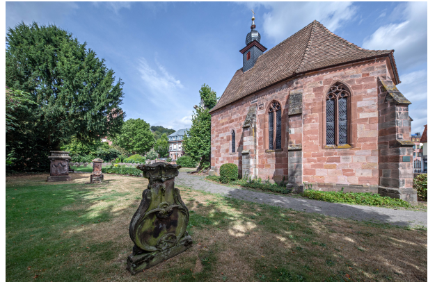
Blick aus dem Südosten auf die Alte Kapelle und den angrenzenden Friedhof in Landstuhl (Harald Kröher, 2018)
