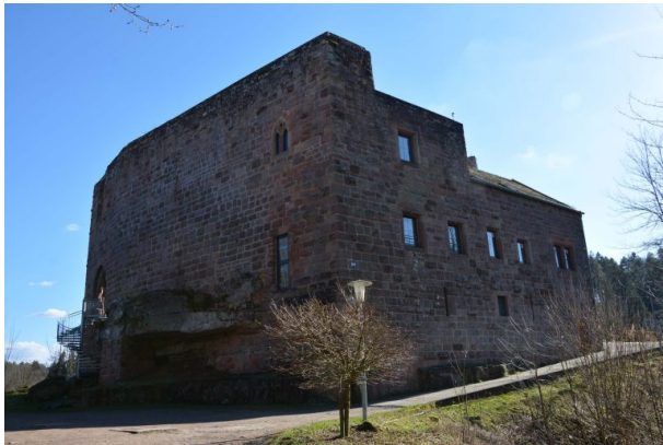
Der Palas der vorderen Burganlage wird heute als Selbstversorgerheim genutzt (Sonja Kasprick, 2019)
