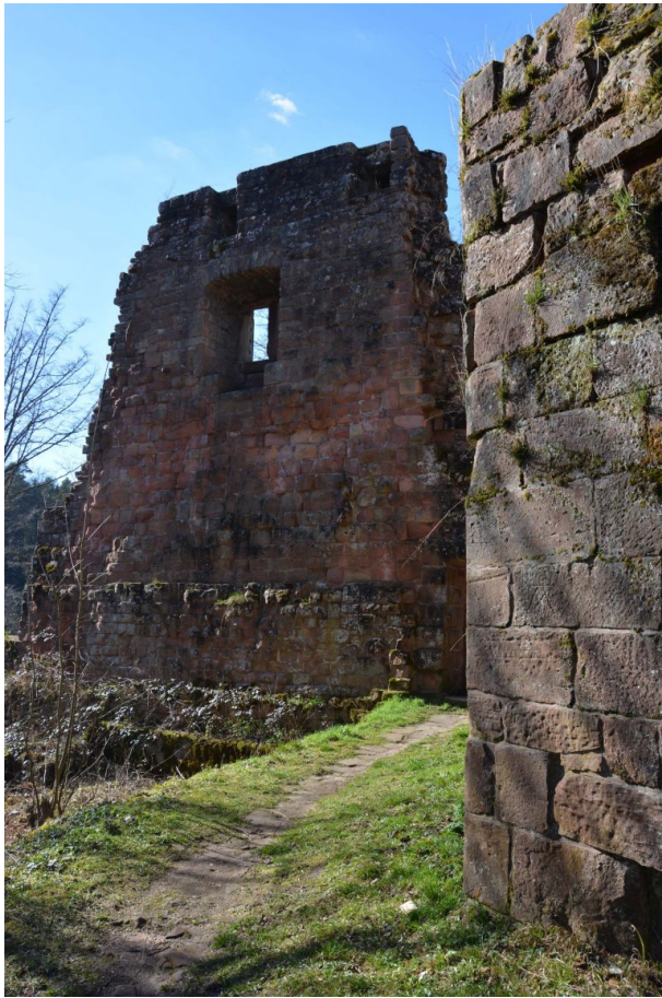
Überreste des ehemaligen Wohnhauses der hinteren Burganlage (Sonja Kasprick , 2019)
