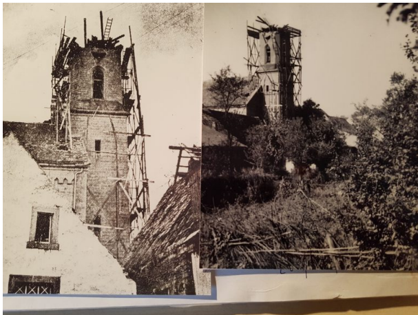
Nach Unwetter zerstörter Kirchturm der Protestantischen Kirche in Unkenbach 1939 (Arno Mohr, 2019)
