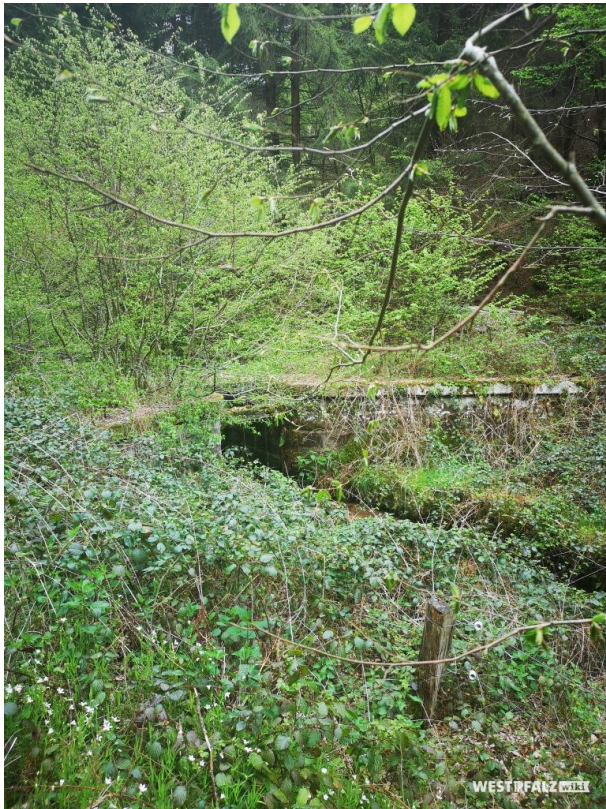
Absperrbauwerk des Felsenthaler Woogs auf der Wasserseite (Anja Jung, 2019)
