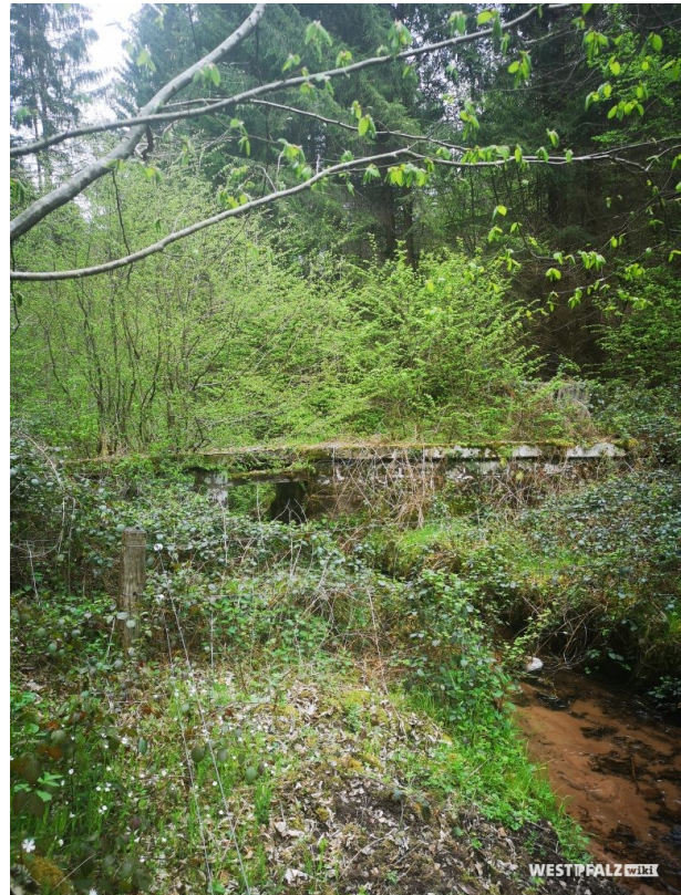
Absperrbauwerk des Felsenthaler Woogs auf der Wasserseite (Anja Jung, 2019)
