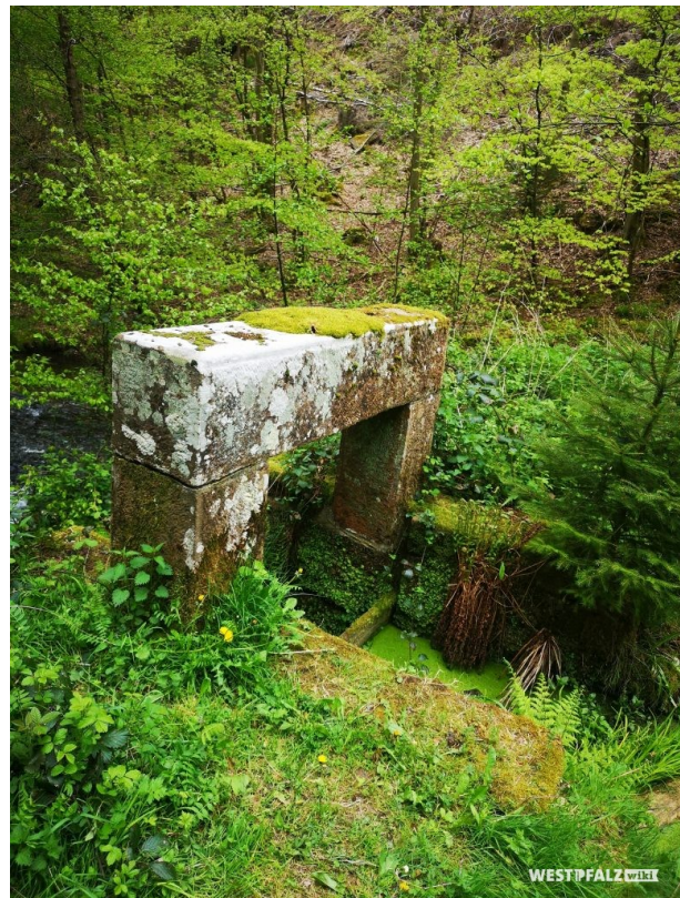
Absperrbauwerk mit offenem Durchlass bis auf die Dammsohle und Aufstauen durch Holzbohlen (wasserabgewandte Seite) (Anja Jung, 2019)
