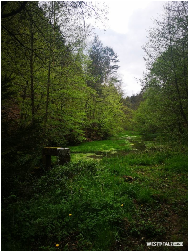
Absperrbauwerk am Finsterthaler Woog (Anja Jung, 2019)
