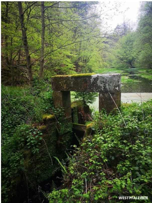
Absperrbauwerk mit offenem Durchlass bis auf die Dammsohle und Aufstauen durch Holzbohlen (wasserabgewandte Seite) (Anja Jung, 2019)
