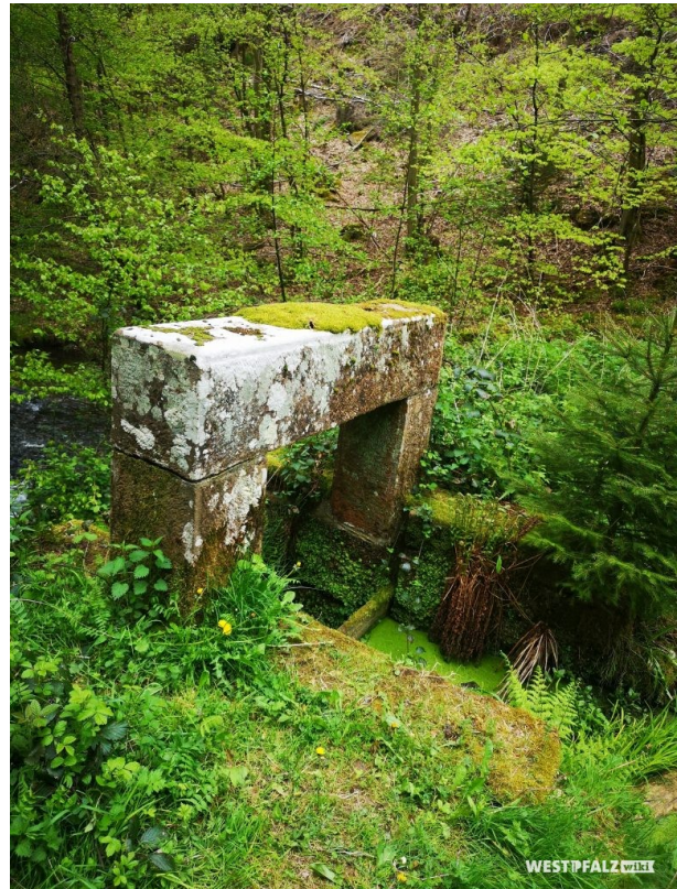
Absperrbauwerk mit offenem Durchlass bis auf die Dammsohle und Aufstauen durch Holzbohlen (wasserabgewandte Seite) (Anja Jung, 2019)
