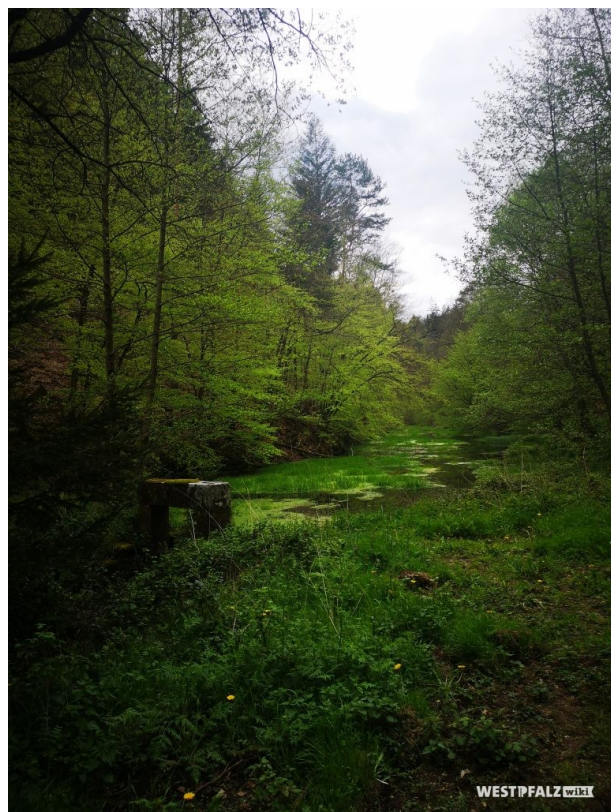
Absperrbauwerk am Finsterthaler Woog (Anja Jung, 2019)
