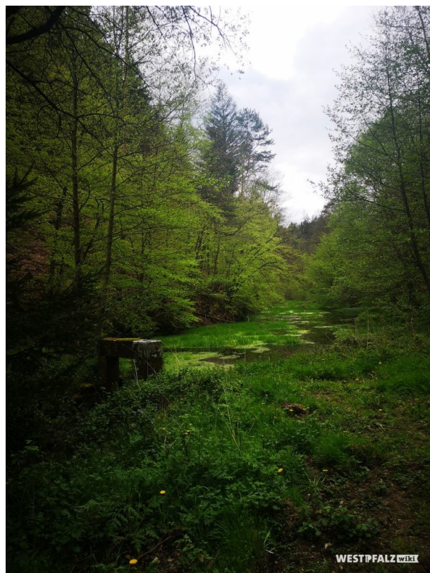
Absperrbauwerk am Finsterthaler Woog (Anja Jung, 2019)
