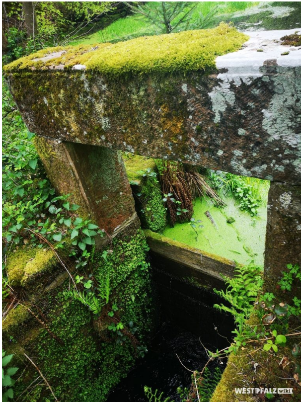
Absperrbauwerk mit offenem Durchlass bis auf die Dammsohle und Aufstauen durch Holzbohlen (Anja Jung, 2019)
