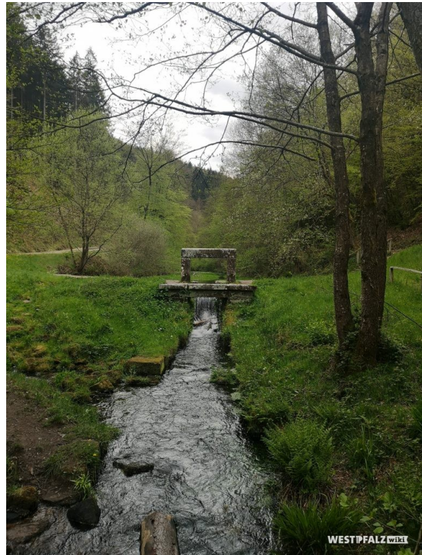
Absperrbauwerk mit Überlauf-Steinkaskade,renoviert (Anja Jung , 2019)
