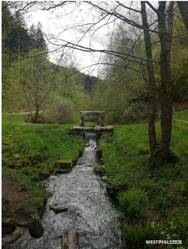
Absperrbauwerk mit Überlauf-Steinkaskade,renoviert (Anja Jung , 2019)
