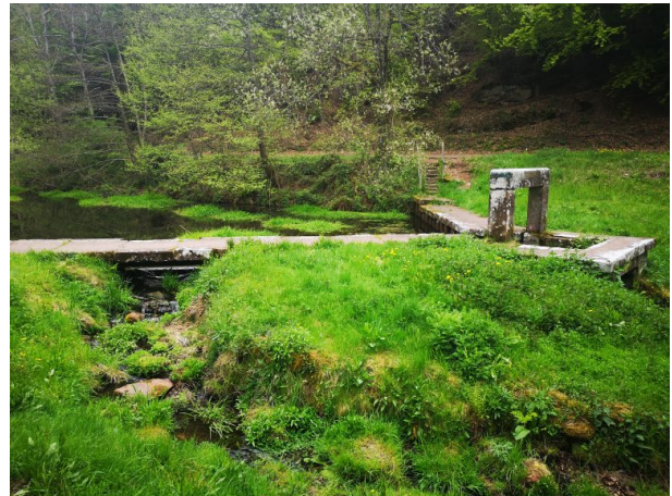
Biederbacher Klause, Absperrbauwerk mit Sandsteinmauer auf der Wasserseite (Anja Jung, 2019)
