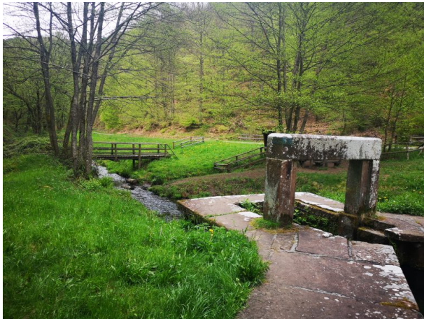
Absperrbauwerk beim Biedenbacher Woog (Anja Jung , 2019)
