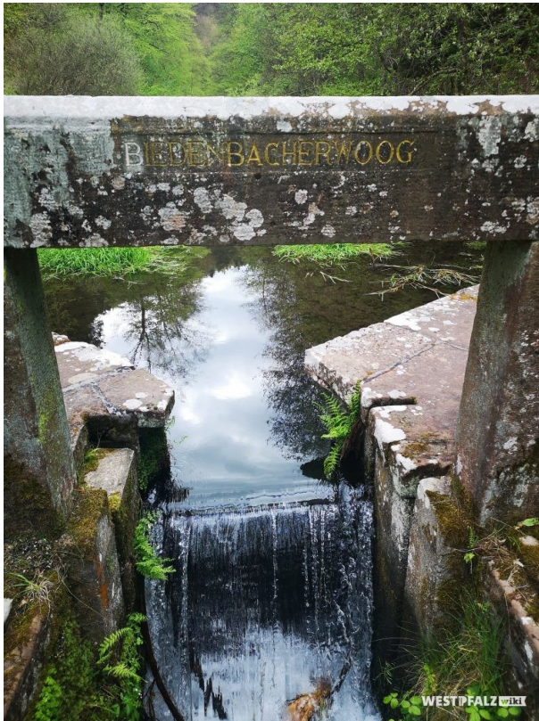
Wasserauslauf am Absperrbauwerk mit Sandsteinfassung, in dem die Inschrift des gleichnamigen Rittersteins integriert ist (Anja Jung , 2019)
