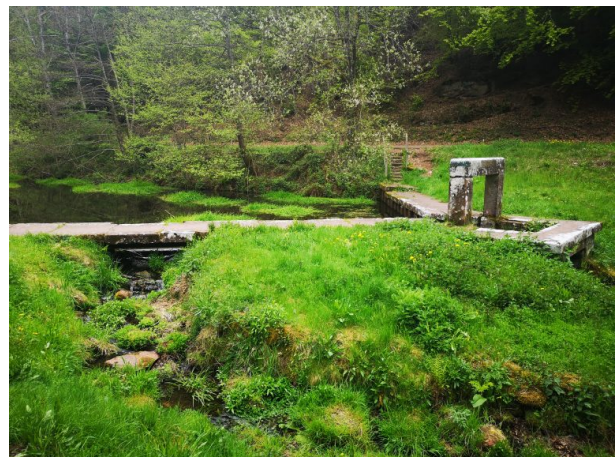
Biedenbacher Klause, Absperrbauwerk mit Sandsteinmauer auf der Wasserseite (Anja Jung, 2019)
