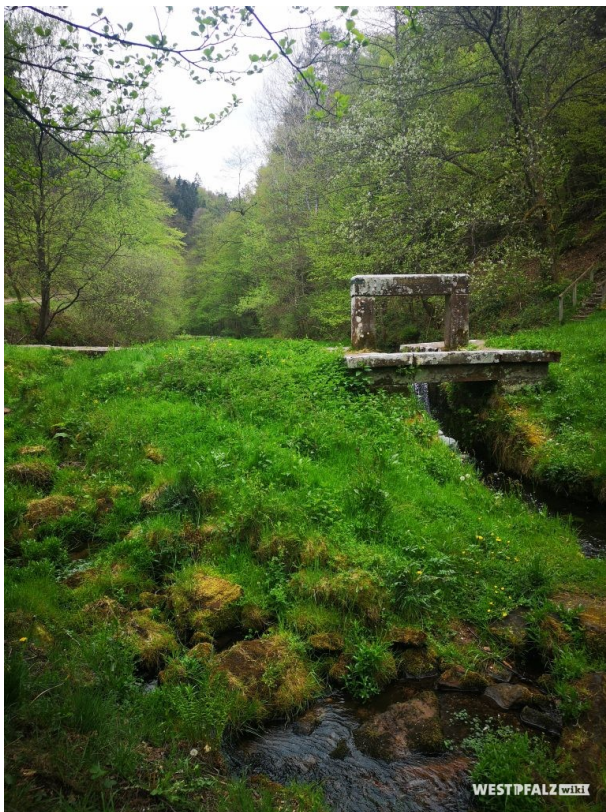
Absperrbauwerk mit Sandsteinstaudamm am Leinbach (Anja Jung , 2019)
