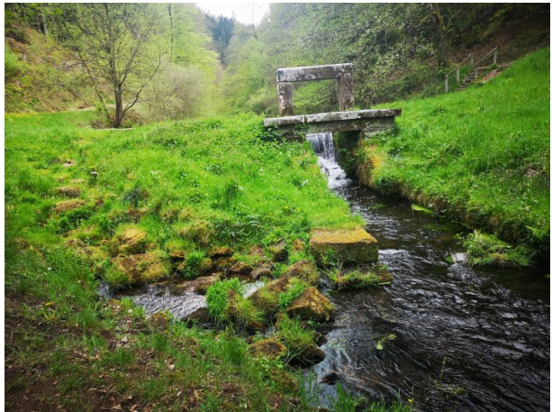
Absperrbauwerk unterer Biedenbacher Woog mit offenem Durchlass und Sandsteinmauer (Anja Jung, 2019)
