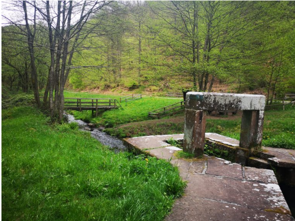
Absperrbauwerk beim Biedenbacher Woog (Anja Jung , 2019)
