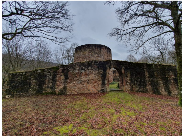
Sprengelburg bei Oberweiler im Tal (Peter Herzer, 2021)
