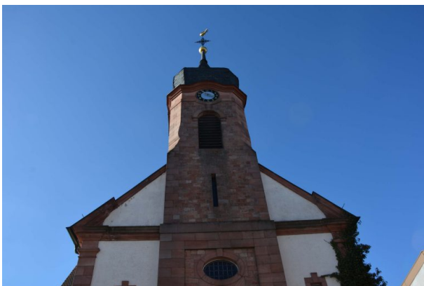
Der barocke Kirchturm mit Zwiebelhaube. (Sonja Kasprick, 2018)
