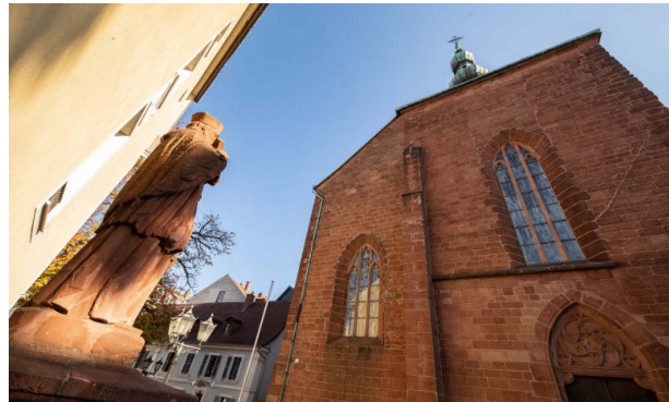
Blick auf die Portalseite im Westen. Links im Bild und außerhalb der Kirche steht eine Figur aus Sandstein mit einer Bibel in den Händen auf einem Sockel (Harald Kröher, 2018)
