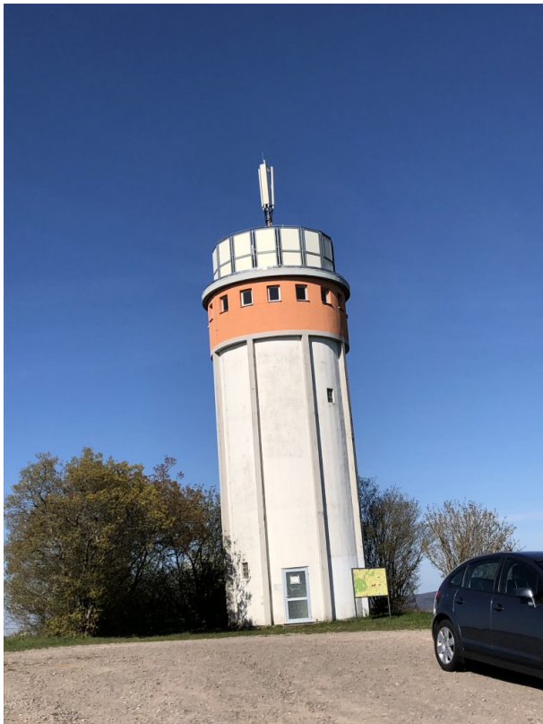
Wasserturm am Sangerhof (Dana Taylor, 2021)
