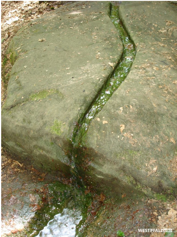
Steinplatte der Kaskade mit in den Stein gemeißelter Wasserrinne (Manfred Grad, 19.5.2018)
