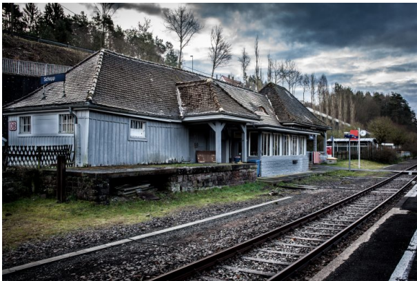
Einer der Haltepunkte der ehemaligen Moosalbtalbahnstrecke: Bahnhof in Schopp (Hörle, Benjamin, 2018)
