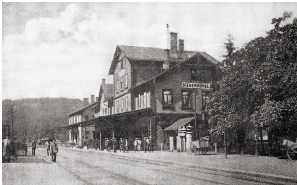
Bahnhof Biebermühle im Jahr 1912 (1912)
