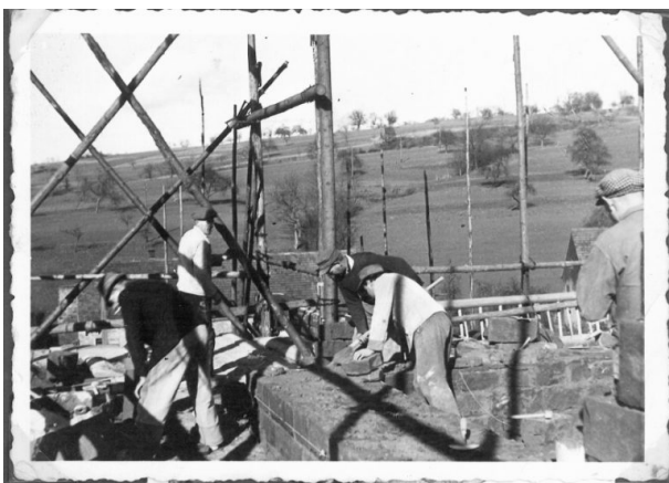
Bauarbeiten an der Kirche (Werner Kleber, um 1950)
