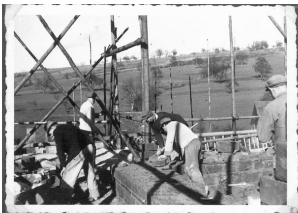
Bauarbeiten an der Kirche (Werner Kleber, um 1950)
