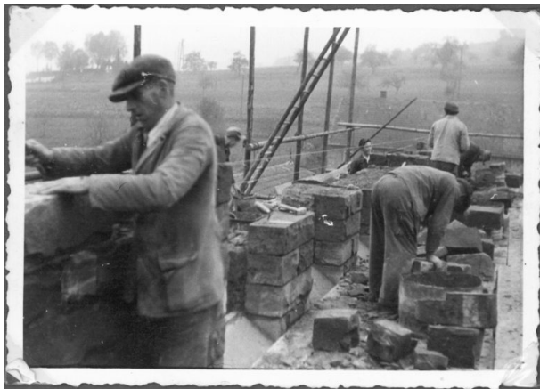
Bauarbeiten an der Kirche (Werner Kleber, um 1950)
