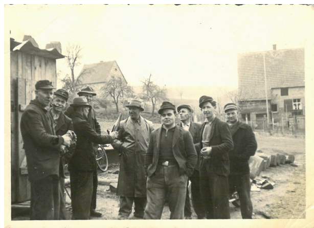
Bauarbeiter bei der Kirche (Werner Kleber, um 1950)
