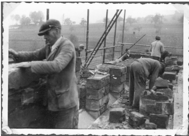
Bauarbeiten an der Kirche (Werner Kleber, um 1950)
