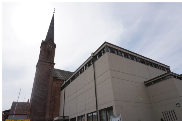
Seitenansicht der katholischen Kirche in Bruchmühlbach (Dana Taylor, 2020)
