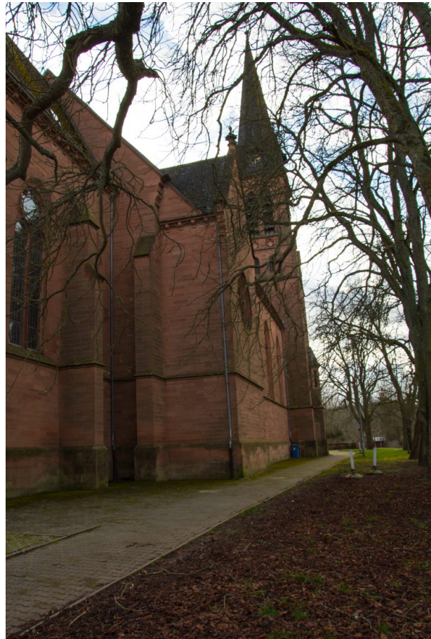
Das Langhaus der katholischen Kirche in Otterbach auf der Südseite (Sonja Kasprick, 2020)
