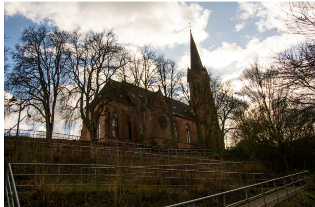
Südseite der katholischen Kirche in Otterbach mit Treppenaufgang (Sonja Kasprick, 2020)
