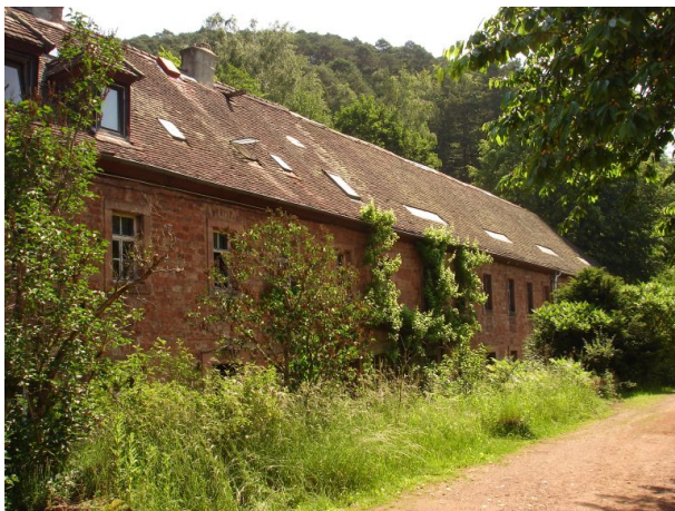
Ehemaliges Blech- und Walzwerk (Manfred Grad, 2018)
