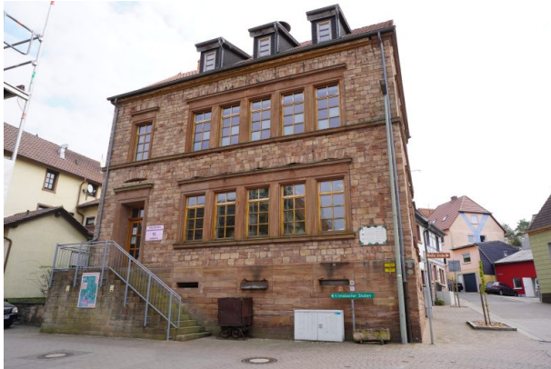
Pfälzisches Bergbaumuseum in Imsbach (Dana Taylor , 2020)
