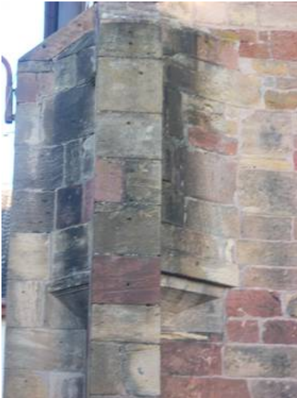
Strebpfeiler und Erker an der Nordwestecke der Außenmauer der Alten Abtei in Otterberg (VG Otterbach-Otterberg )
